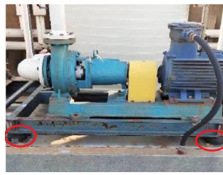
基础减震，降低噪音
